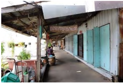
ภาพที่ 3 ลักษณะส่วนสะพานทางเดิน
