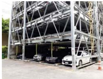
ภาพที่ 3 แสดงอาคารจอดรถ Multi-Story Parking
