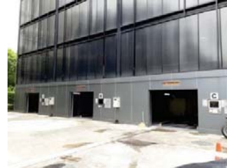
ภาพที่ 2 อาคารจอดรถ Tower Parking
